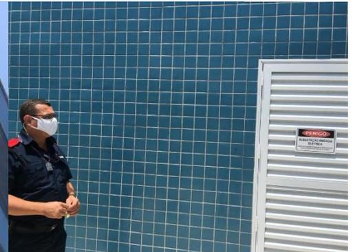
Parede externa com material (painéis de treliças) que proporciona ventilação e luminosidade. Em azul o revestimento de alta durabilidade. O projeto original previa apenas pintura e não o ladrilho.
