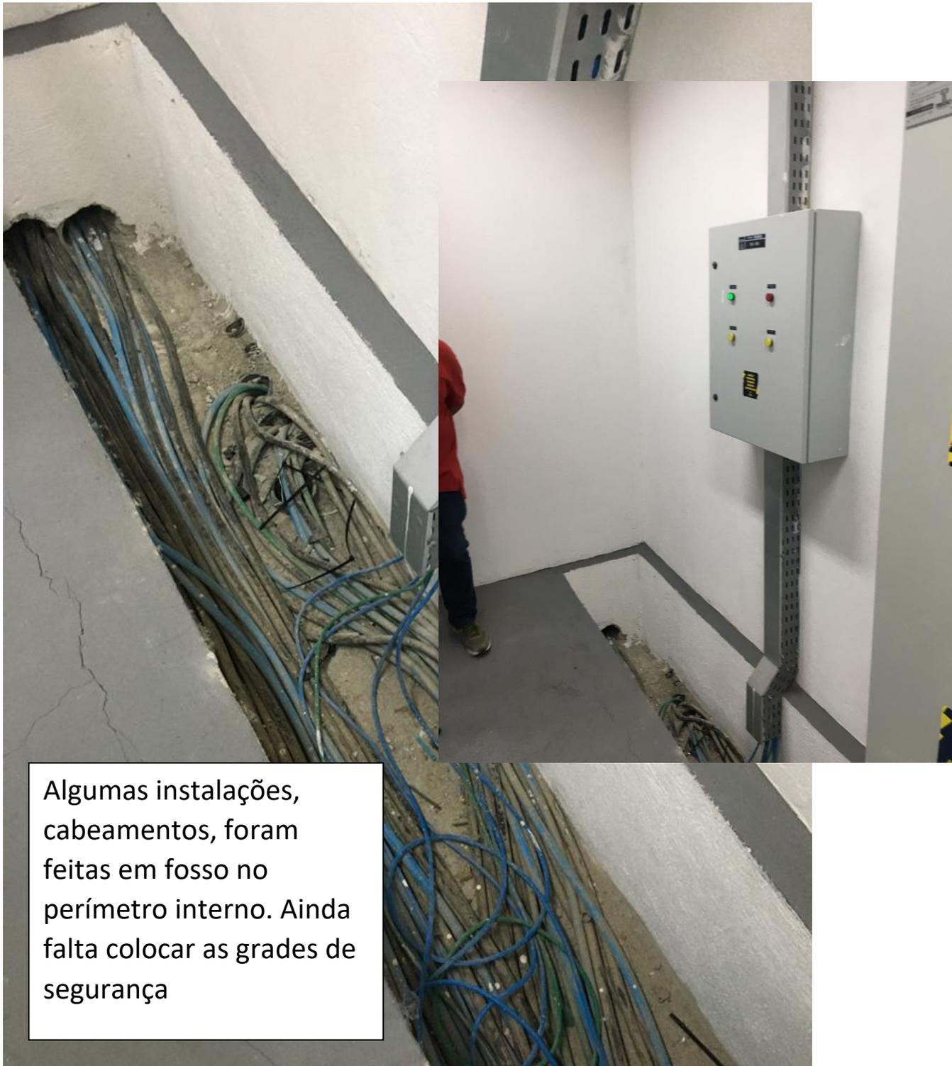
Algumas instalações, cabeamentos, foram feitas em fosso no perímetro interno. Ainda falta colocar as grades de segurança
